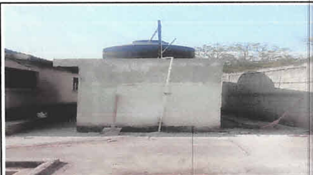
Foto 2: pintado, lijado de paredes, cambio de Tubería de agua
