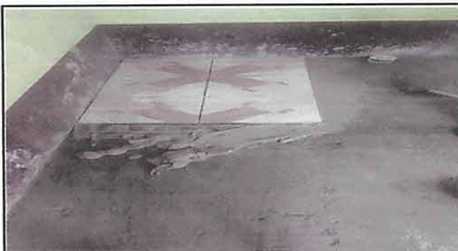
Foto 3: instalación de piso cerámico
