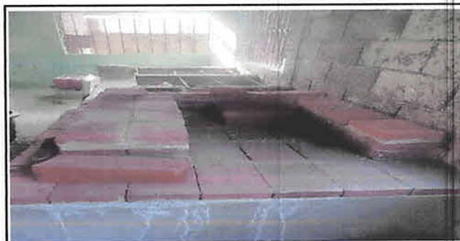
Foto 6: reparación de galleton y hornilla de la cocina
